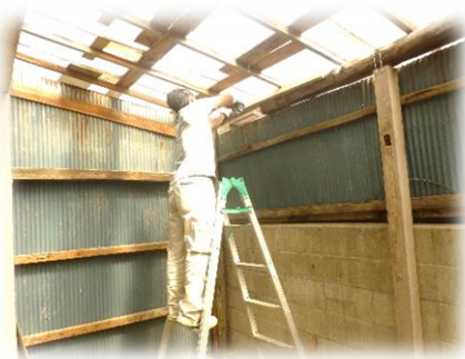
北側倉庫の整理と屋根の修繕
